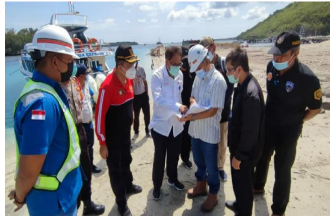
Pengawasan atas Pembangunan Dermaga Sampalan, Bias Munjul, Kedisan, Dermaga Kuburan dan Desa Trunyan Danau Batur - Bali
