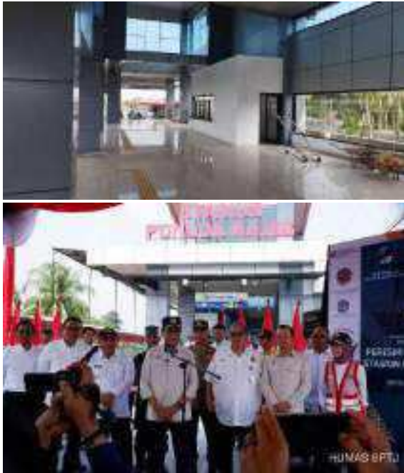
Gambar III. 18 Pembangunan Stasiun Pondok Rajeg
