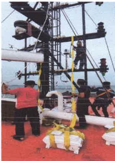
Gambar 87. Pemasangan Radar pada Kalimasadha P. 115
