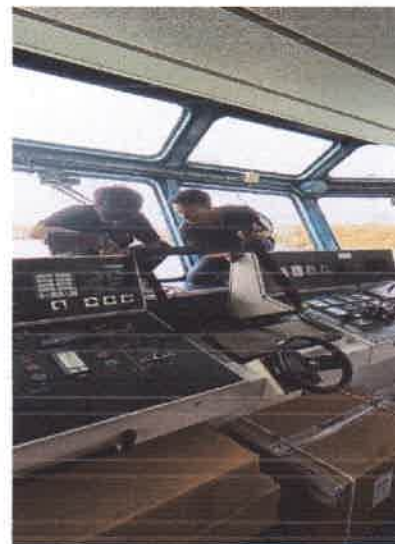
Gambar 88. Pemasangan Radar Pada KN. Sarotama P. 112
