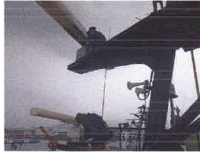
Gambar 86. Pengadaan Radar Kapal Patroli KPLP Pemasangan Radar Pada KN. Alugara P. 114
